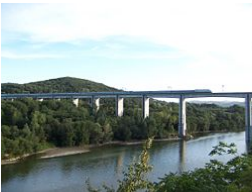
Un ETR 500 sul viadotto di Rondine
